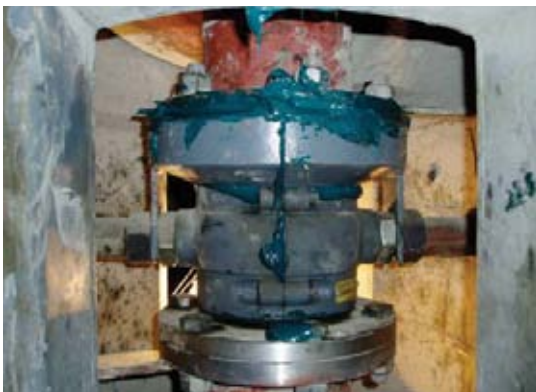
Doppelbolzenhänger aus Grauguss in einer vertikalen Welle
